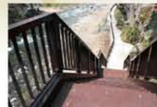
⑧湯原橋たもとの出入口階段 しっかりとした手すりを採用し、安全面と安心感を確保。足下も快適です。
